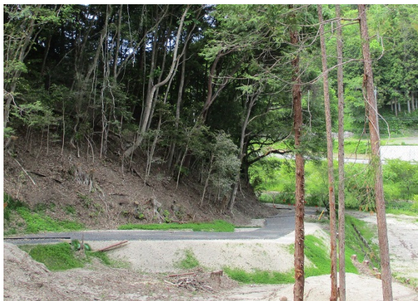
「地元住民が里山林を保全活用するための管理道の整備」
