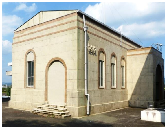
豊橋市上水道施設下条取水場旧ポンプ室 外観南西から (豊橋市教育委員会 提供)
