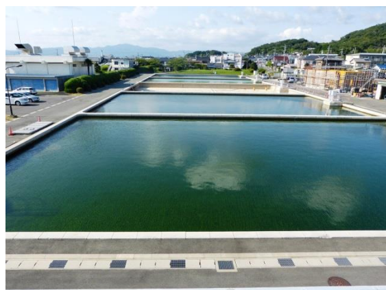
豊橋市上水道施設小鷹野浄水場緩速ろ過池 全景南から (豊橋市教育委員会 提供)
