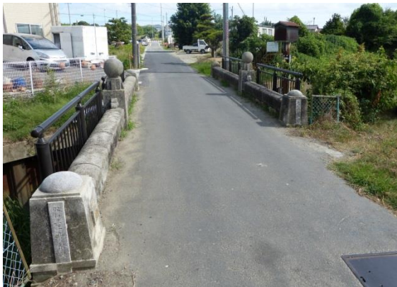
豊橋市上水道施設大江川水道橋 小鷹野浄水場方向を望む (豊橋市教育委員会 提供)
