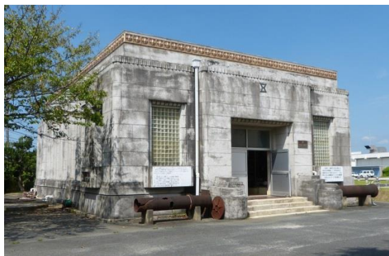
豊橋市上水道施設小鷹野浄水場旧ポンプ室 外観南から (豊橋市教育委員会 提供)
