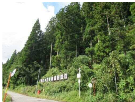
施工後 7 年目（平成 29 年）
