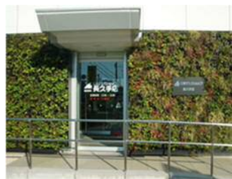
壁面緑化（長久手市）
