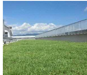
公共施設の屋上緑化（愛西市）
