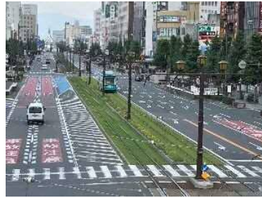
軌道緑化（豊橋市）
