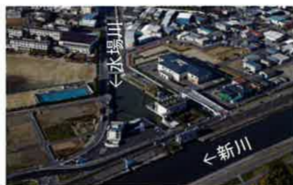
水場川排水機場
