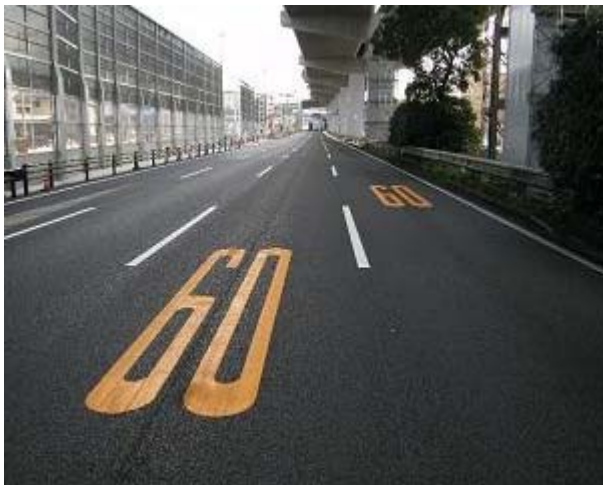
写真1 低騒音舗装（排水性舗装）の例 （国道23号 名古屋市緑区大高町）
