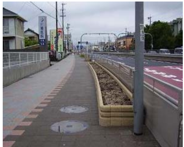
写真2 遮音壁設置の例 （国道19号 春日井市若草通）
