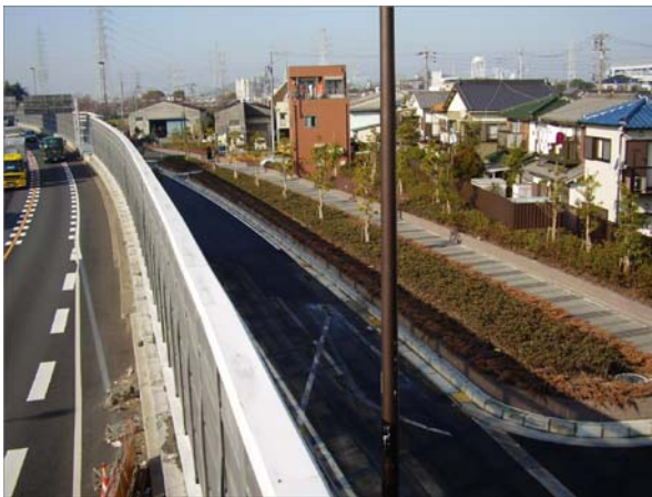
写真3 環境施設帯設置の例 （国道23号 名古屋市港区品川町）
