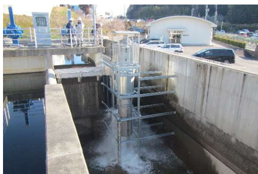
西尾地区（西尾市）の状況
