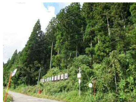
施工後 7 年目（平成 29 年）
