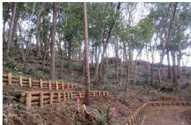
整備前（写真上）、整備直後（写真下）
