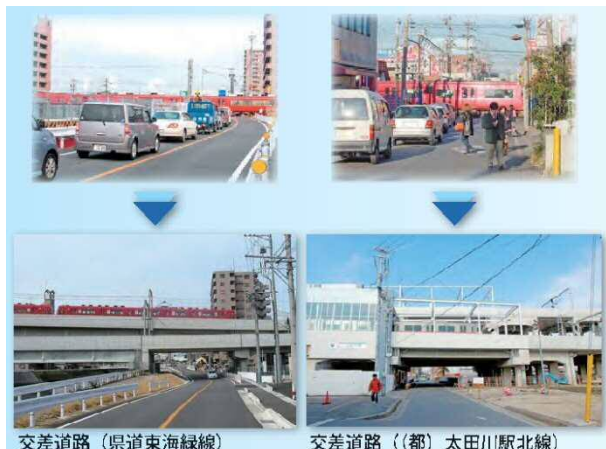
【立体交差箇所の状況】
