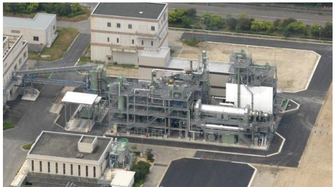
下水汚泥燃料化施設（衣浦東部流域下水道炭化炉）
