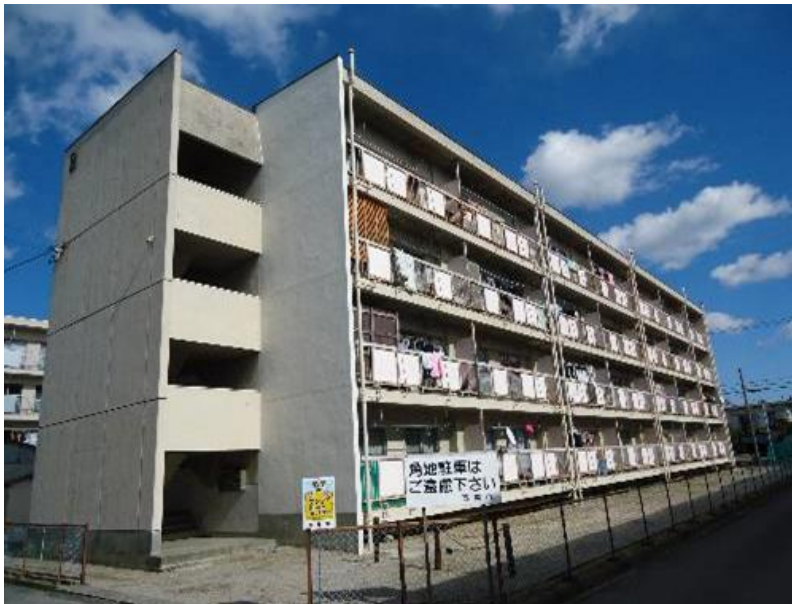
施工前(B棟)
