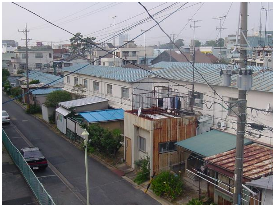
施工前(A、B、C、D棟)
