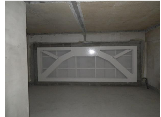
施工後(耐震ブレース設置)
