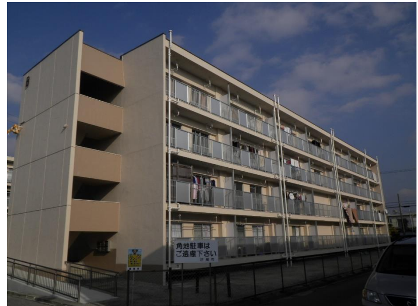
施工後(B棟)
