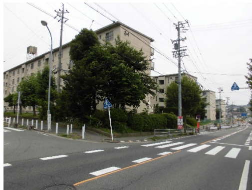
北西方より調査対象地
