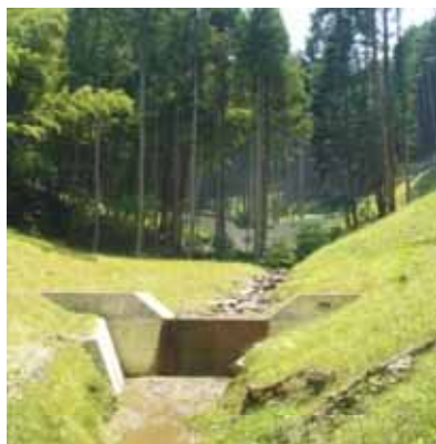
予防治山事業(山地災害総合減災対策治山) 谷止工・床固工(新城市下吉田地内)
