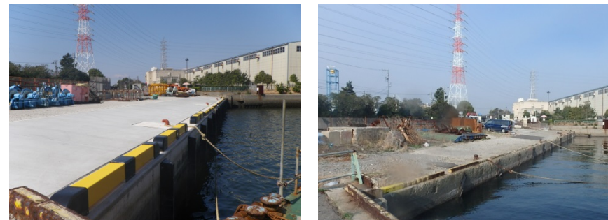
③武豊北ふ頭物揚場補修(衣浦港)
