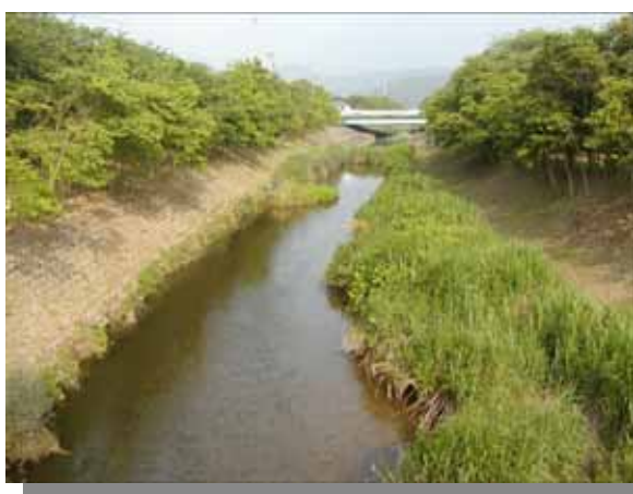
写真 3-12 水辺の緑の回廊整備 (朝倉川 豊橋市)
