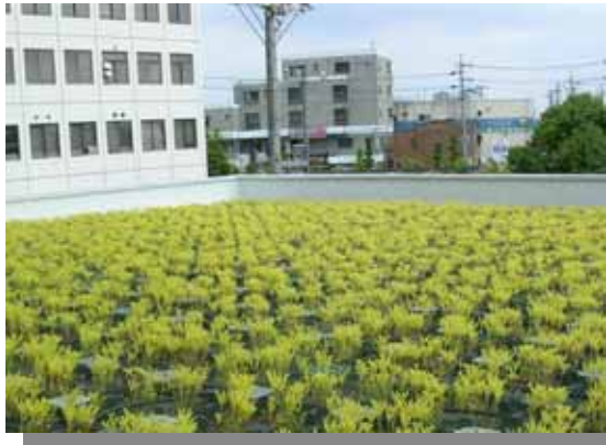
写真 3-19 屋上緑化（安城市）
