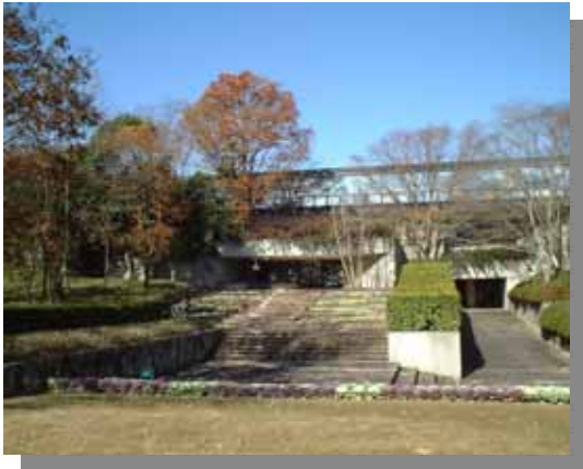
写真 3-3 緑化センター本館
