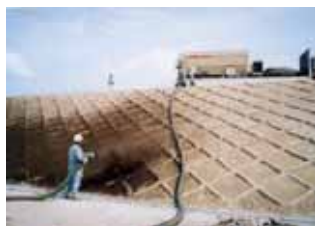
パークブロー工法
