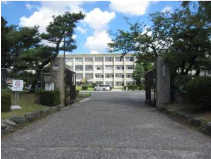
愛知県立碧南高等学校正門門柱 (旧愛知県碧南国民学校正門) 正門 南から (愛知県教育委員会提供)
