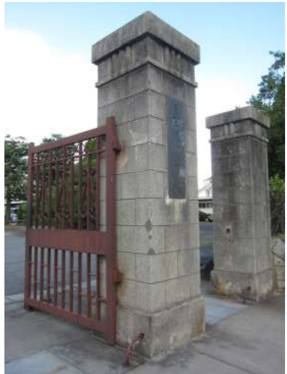
愛知県立鶴城丘高等学校正門門柱 (旧愛知県蚕糸学校正門) 東門柱 南西から (愛知県教育委員会提供)
