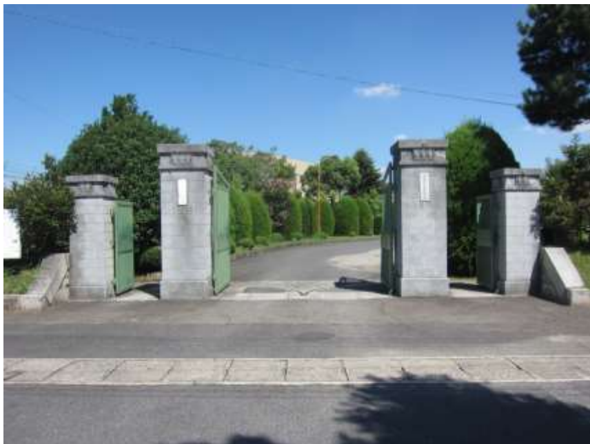
愛知県立小牧高等学校正門門柱 (旧愛知県小牧中学校正門) 正門 南から (愛知県教育委員会提供)
