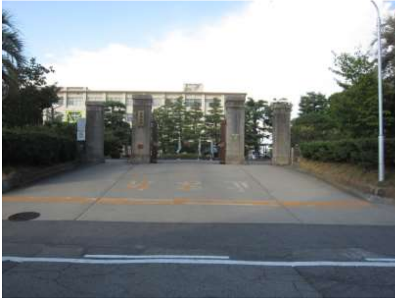
愛知県立鶴城丘高等学校正門門柱 (旧愛知県蚕糸学校正門) 正門 南から (愛知県教育委員会提供)
