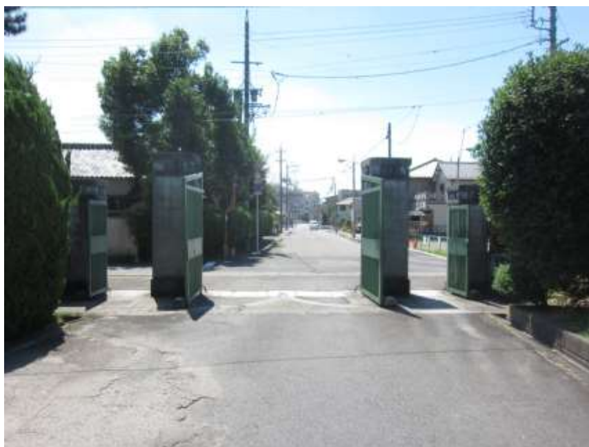
愛知県立小牧高等学校正門門柱 (旧愛知県小牧中学校正門) 正門 北から (愛知県教育委員会提供)
