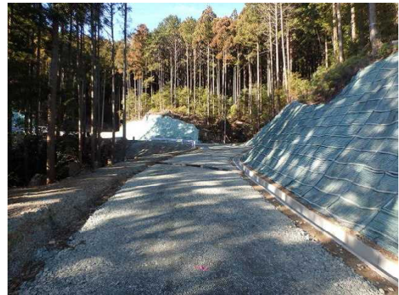
上新戸黒淵線の完了状況 (H28.1.22 新城市)
