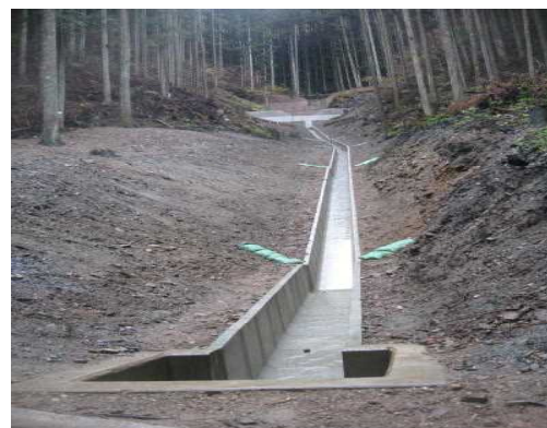
平成27年度流路工施工地 (H27.11.18 東栄町振草)
