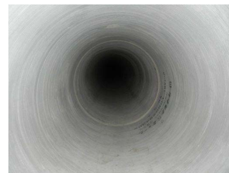
施工後(管きょ内部)
