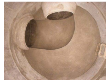
施工後(マンホール内部)
