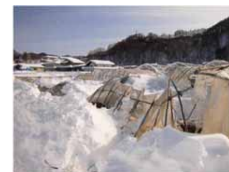
長野県南相木村の花きハウスの倒壊 （長野県農業技術課提供）
