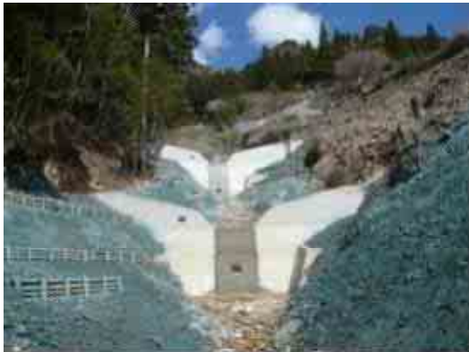
予防治山事業 谷止工(設楽町平山地内)
