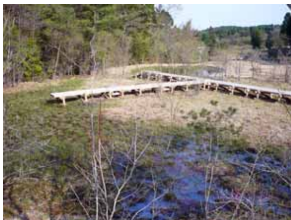
農地環境整備事業により設置した遊歩道
