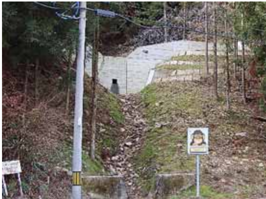
緊急小規模治山対策事業(豊根村坂宇場地内)
