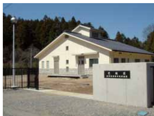
集落排水施設(新城市巴地区)
