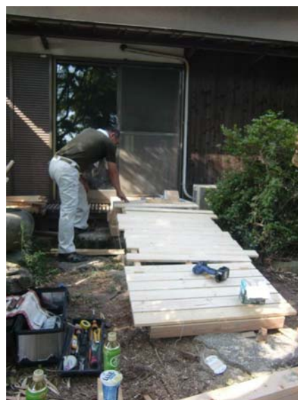
部屋へ入るためのスロープ作り
