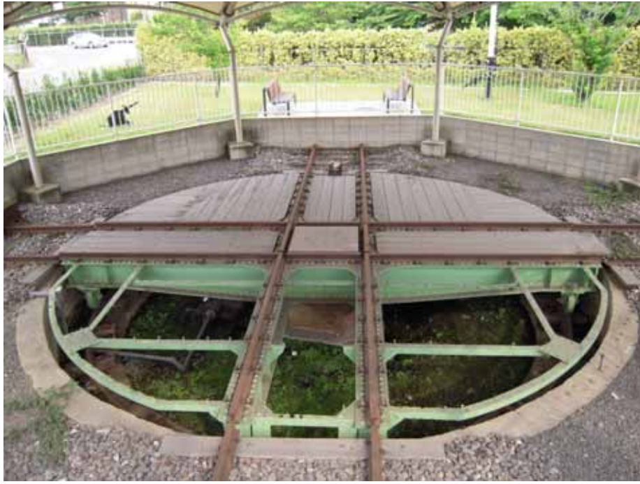
旧国鉄武豊港駅転車台全景
