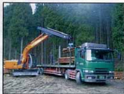
サテライト土場で大型トレーラに木材を積み込む
