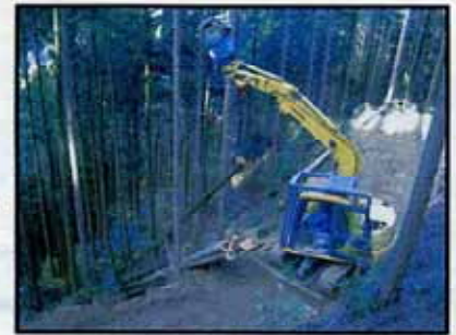
スイングヤードによる集材作業
