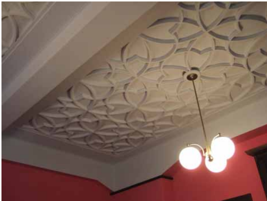
名古屋陶磁器会館旧応接室天井部
