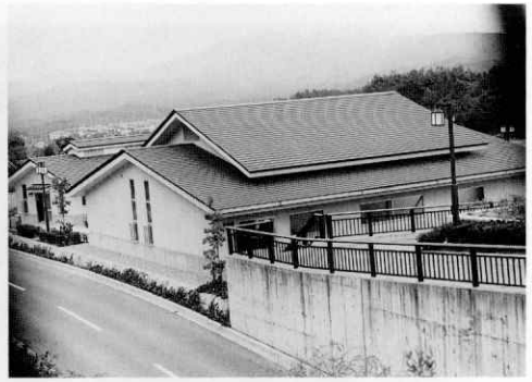
⑤ 古窯館現況 手前:南山9号窯 奥:南山8号窯南から
