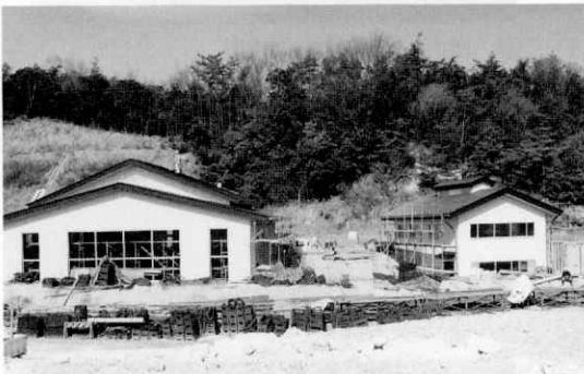
② 古窯館建設工事時(東から)左:南山9号窯 右:南山8号窯
