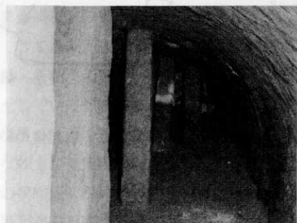
写真3 窯内の支柱列
