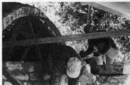
写真2 燃焼室の製作
