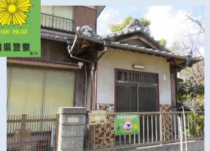
↓プレート取付状況
