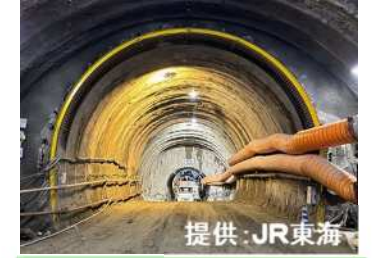
③西尾非常口・保守基地
