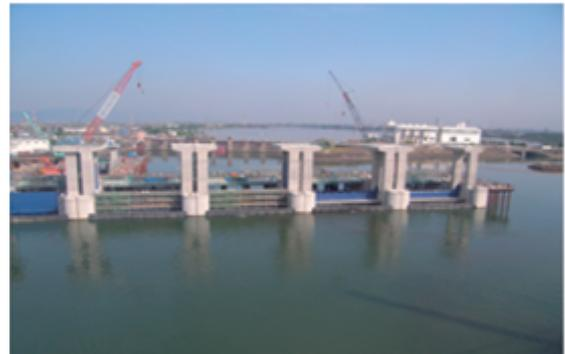
高潮、津波遡上を防ぐための河口部の施設。老朽化・耐震・治水の各対策のため改築中。（飛鳥村）
