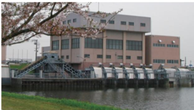
低地に流れ込んだ雨水をポンプにより強制的に川に汲み出す施設。2008年完成。（蟹江町）
