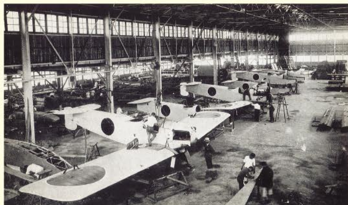
愛知時計電機株式会社機体組立工場(1927年)
