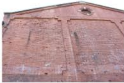
半田赤レンガ建物 (半田市)
